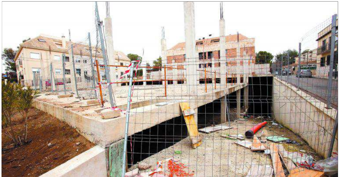
El único edificio de viviendas sin finalizar de Poblete, en la avenida de Ciudad Real con la calle Olmos.
